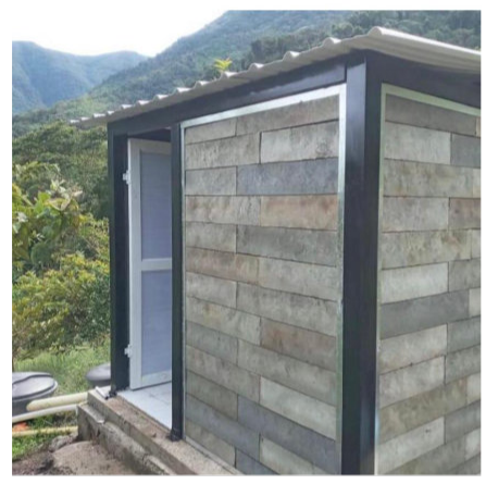
Estructura con bloques de madera plástica
